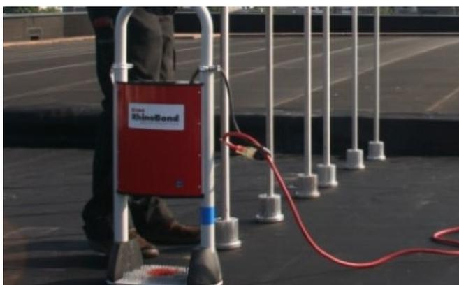
Fig. 2 – Système de fixation OMG RHINO BOND
