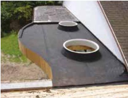
La membrane Tridex EPDM reste élastique, ne nécessite pas d'entretien, est à 100% résistante à l'ozone et aux rayons UV. On peut marcher dessus et elle dispose d'un certificat pour la récupération de l'eau de pluie.
